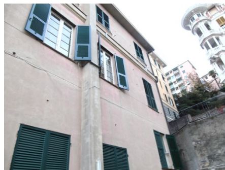
Figura 8.3 – Particolare muratura da isolare
