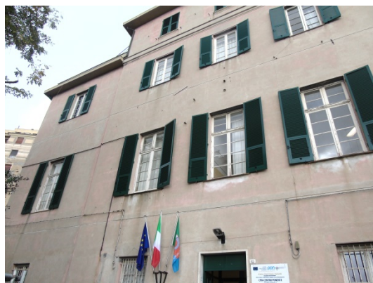
Figura 1.1 - Vista della facciata esposta a Sud
