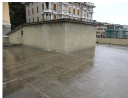
Figura 8.5 - Particolare copertura piana su cui intervenire.
