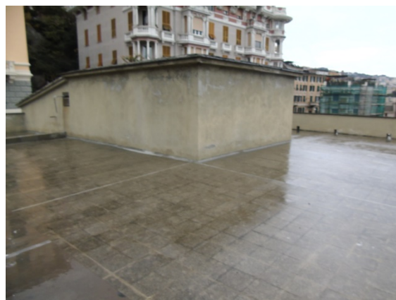
Figura 4.2 - Particolare della copertura
